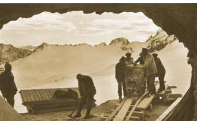
Tunneldurchbruch zum Zugspitzplatt
